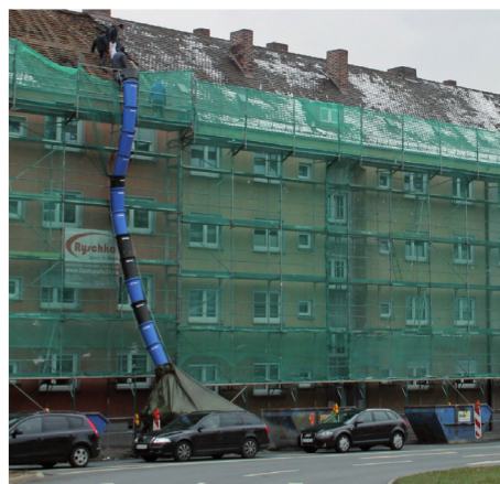
Sanierungsarbeiten in der Poppenreuther Straße 2-8.
