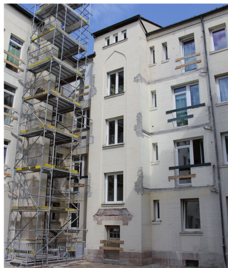
Baustelle Amalienstraße 68 in Fürth.
