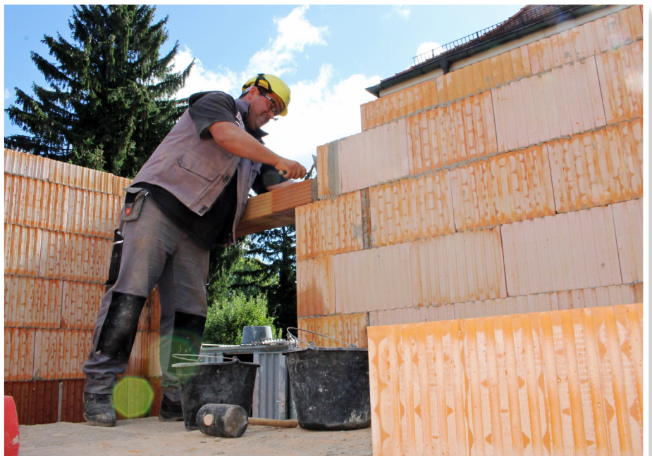
Mauern mit Porotonziegeln auf der Baustelle Widderstraße 25.
