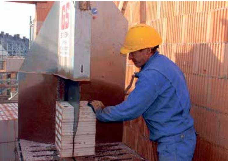
Problemloses Schneiden der mit Perlit gefüllten Steine mit der Säge.
