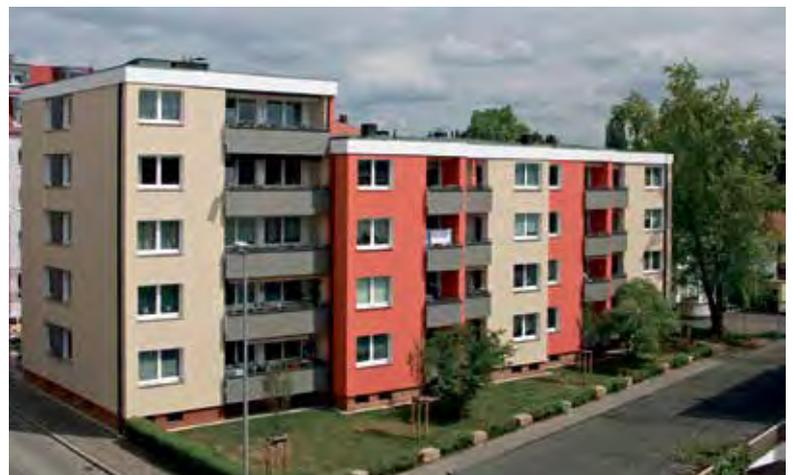
Erscheinungsbild. Zu erheblichen Einsparungen von Heizenergie wird die Dämmung der Kellerdecken und Dachböden führen. Als begleitende Instandsetzungsarbeiten erhielt die Außenfassade einen neuen Anstrich mit frischen Farben. Alle 21 Wohnungseingangstüren wurden erneuert und die
