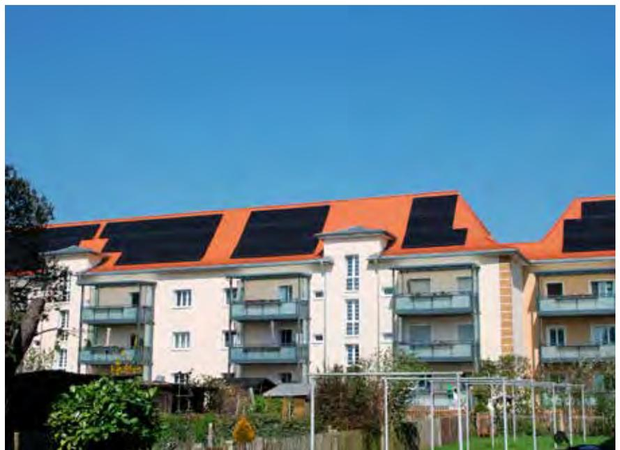
Die energetische Außenhülle, eine hocheffiziente Zentralheizung, dreifachverglaste Fenster und selbst produzierter Ökostrom von den Photovoltaikanlagen auf dem Hausdach sichern den Bewohnern zudem dauerhaft günstige Wohnnebenkosten und reduzieren den CO<sub>2</sub>-Verbrauch deutlich. Die Dämmung nützt aber auch im Sommer, denn durch die schützende Außenhülle bleiben die
