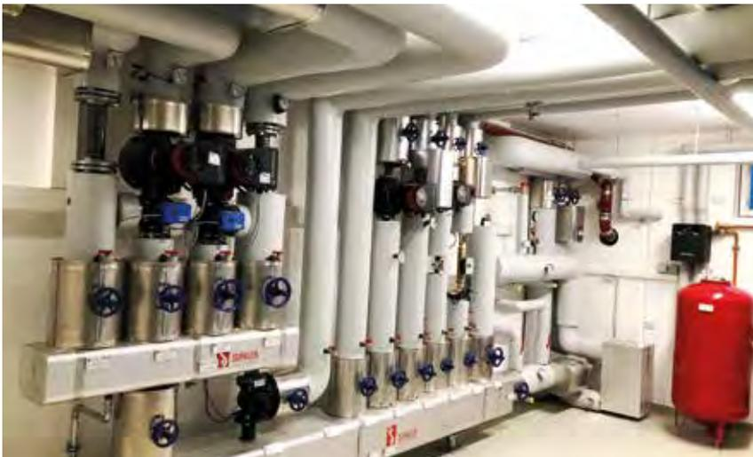
Regelungen zum Vor- und Rücklauf im Heizungskeller für die moderne Fußbodenheizung.
