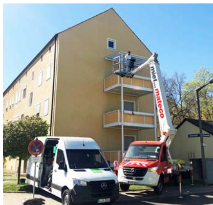
Fassadenreinigung an der Elsterstraße 23.
