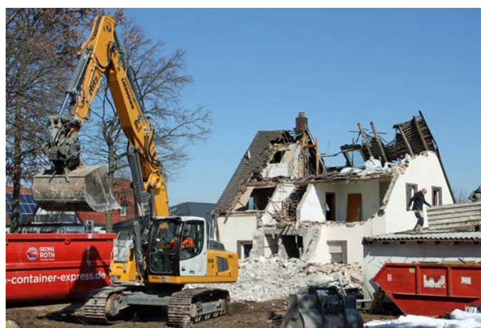
Abbruch der beiden Altgebäude.
