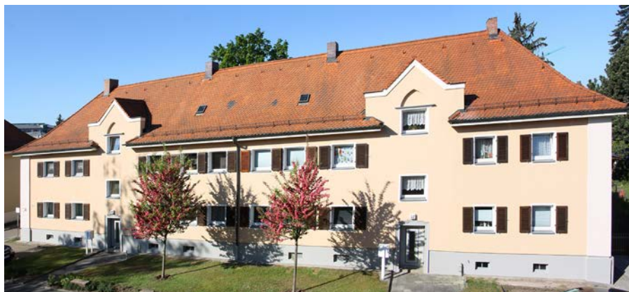
Widderstraße 32, 34 nach der Fassadensanierung.
