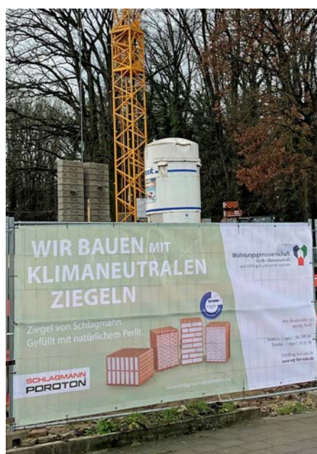
Die Baupläne an der Ronhofer Hauptstraße weist auf die klimaneutralen Ziegel hin.
