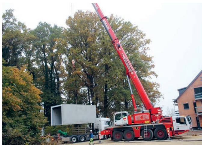
Bautenstand der Ronhofer Hauptstraße 267, 269 zum Ende des Jahres 2021. Rechts: Anlieferung der Fertiggaragen.
