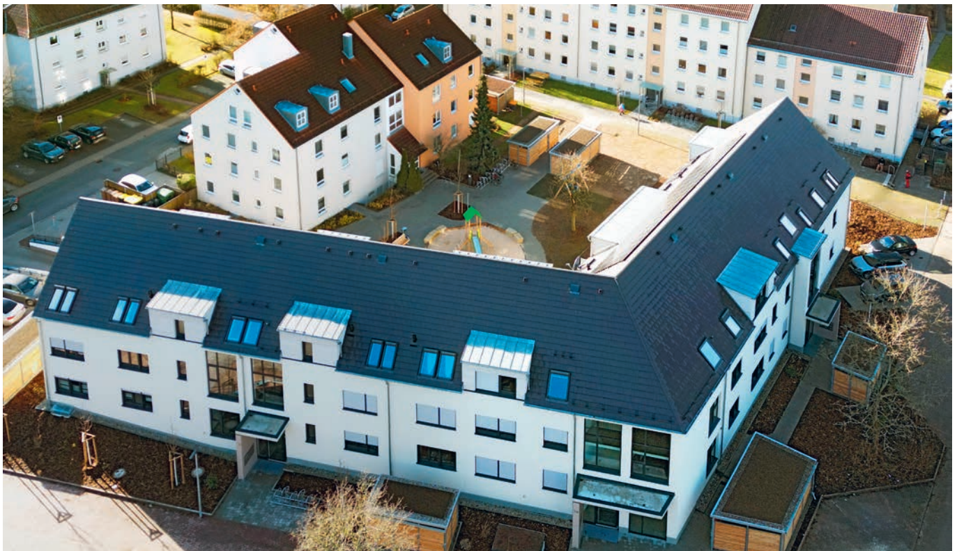
Drohnenaufnahme des Neubaus in der Aternstraße in Oberasbach.
