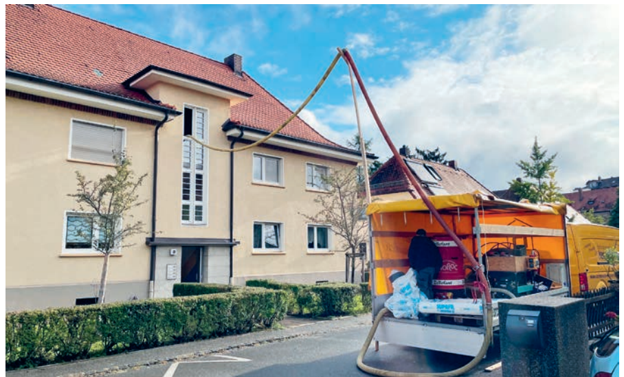
Einfüllen des Dämmstoffes über das Treppenhaus in der Georgenstraße 13.
