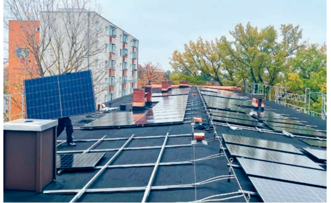
Neue Luftwärmepumpen am Lilienplatz 9 in Oberasbach. Rechts: Montage der Solarmodule auf dem Dach Mauerstraße 26, 28, 30 in Fürth.
