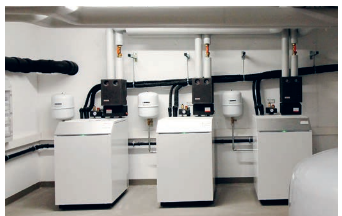
Klimaneutrale Wärmepumpen und Heizungstechnik im Keller Neubau Aternstraße 6, 6 a, 6 b in Oberasbach.
