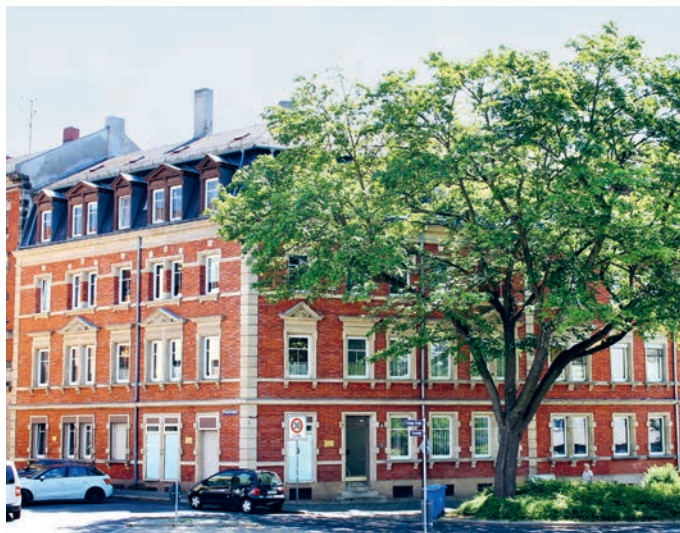
Denkmalgeschütztes Wohnhaus Erlanger Straße 36 in Fürth.
