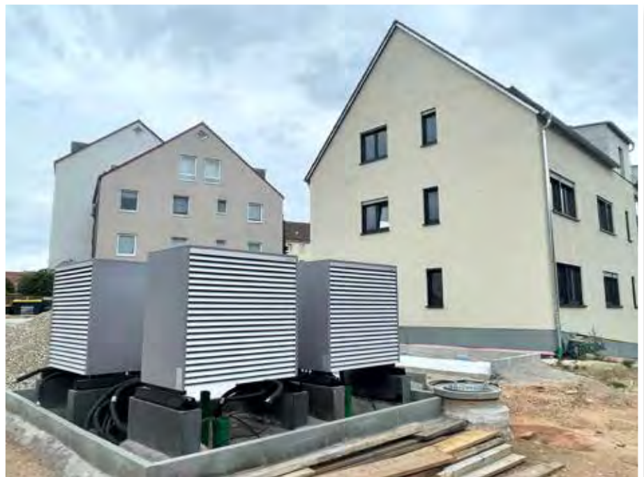
Drei Luftwärmepumpen zur Wärmeversorgung.
