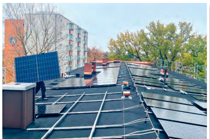
Montage der Solarmodule auf dem Dach der Mauerstraße 26, 28 und 30 in Fürth.
