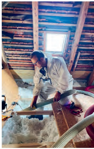
Einfüllen des Dämmstoffes über das Treppenhaus in der Georgenstraße 13 durch Norbert Metscher von der Schreinerei Keppner aus Langenzenn.
