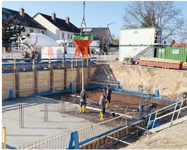
Betonarbeiten am Fundament Kronacher Straße 42.
