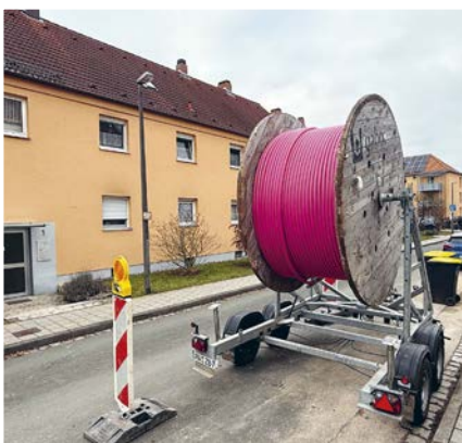
Glasfaserkabel in der Tulpenstraße in Oberasbach.
