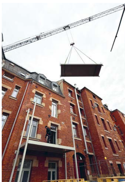
Montage der neuen Balkone im Hof in der Erlanger Straße 36.
