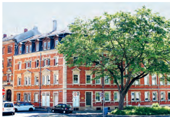
Erlanger Straße 36: Das Projekt zeigt, dass auch im Denkmalschutz eine erhebliche Reduzierung des Heizenergiebedarfs realisiert werden kann.
