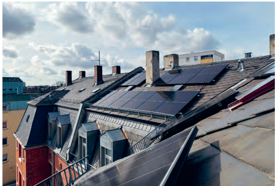
Neue PV-Anlage auf dem Schieferdach der Erlanger Straße 36 in Fürth.
