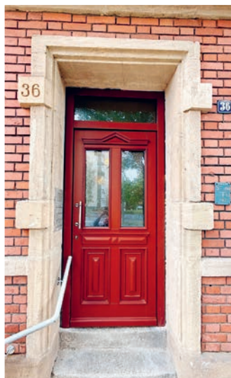
Neue Holztüre in Denkmalrot.
