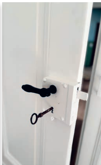
Wieder gangbar gemachtes Kastenschloss aus dem Jahr 1899.
