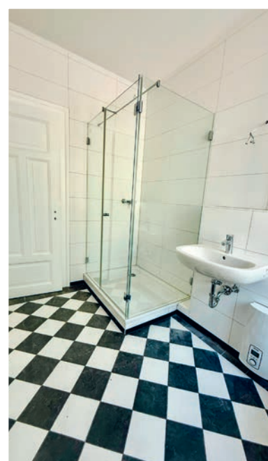
Neues Bad mit stilgerecht diagonal im klassischen schwarz-weißen Schachbrettmuster verlegten Bodenfliesen.
