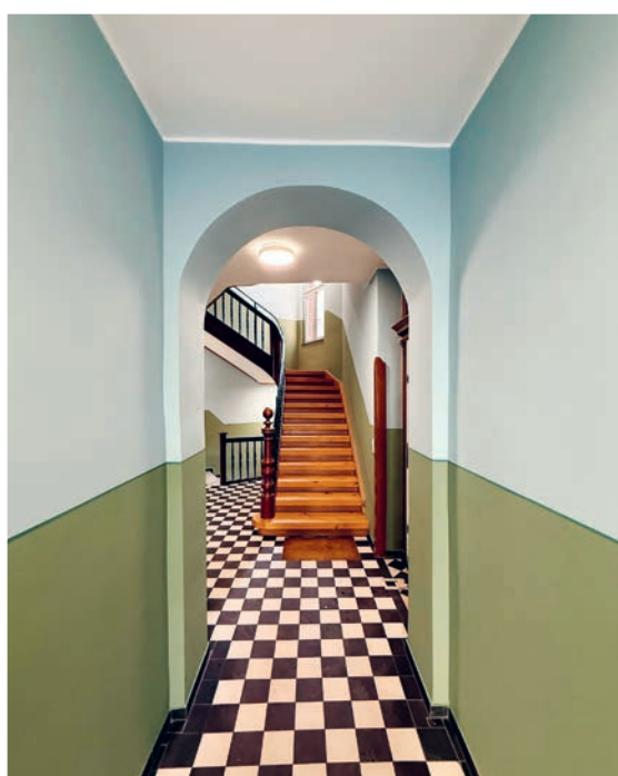
Saniertes Treppenhaus in historisch originalen Befundfarben.
